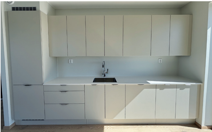
Alle kjøkken er levert av HTH.
