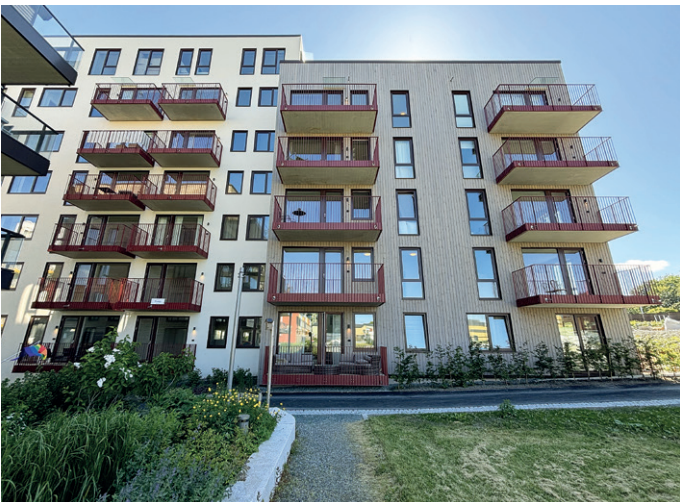
Veksling mellom trekledning og murpuss på veggen mot vest.
